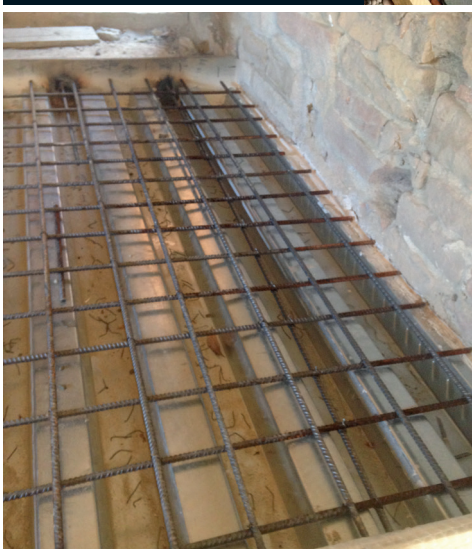
Rete saldata alla lamiera grecata per rendere il getto collaborante.
