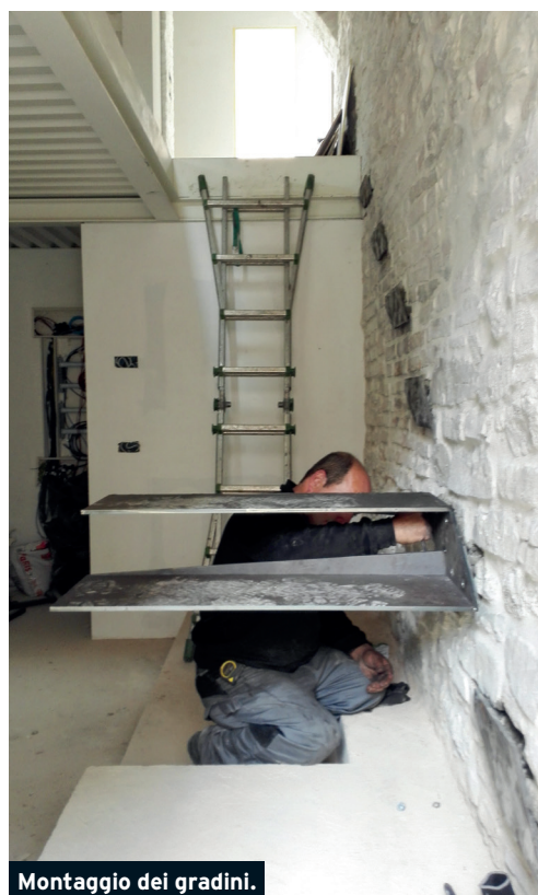
Montaggio dei gradini.
