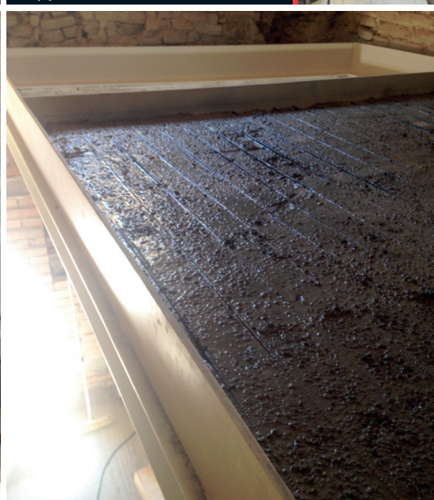
Rete saldata alla lamiera grecata per rendere il getto collaborante.
